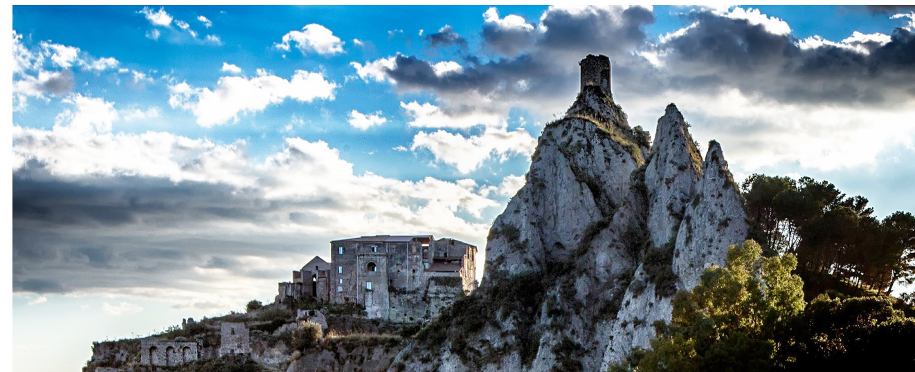
Veduta del Castello e della Torre di Pizzofalcone
